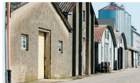
Abrissreif: Im Gegensatz zu den glänzenden Silos im Hintergrund sind die Lagerhallen am Hafen veraltet und sollen verschwinden.
