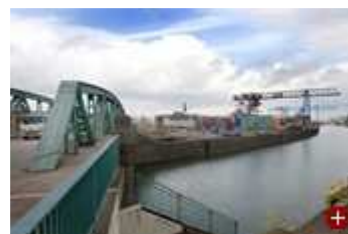
Hafenstadt Frankfurt: Containerumschlag im Osten der Stadt
